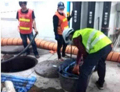
ภาพที่ 2-29 การสูบล้างและดูดตะกอนบำบัดน้ำเสีย อาคาร A และ B
