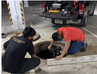
ภาพที่ 2-28 ตรวจสอบบำรุงรักษาระบบบำบัดน้ำเสีย
