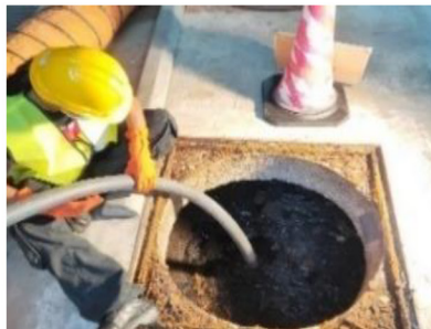
ภาพที่ 2-29 การสูบล้างและดูดตะกอนบำบัดน้ำเสีย อาคาร A และ B
