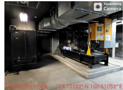
ภาพที่ 2-14 เครื่องกำเนิดไฟฟ้าสำรองอาคาร Tower A และ Tower B
