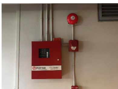
ภาพที่ 2-23 ระบบป้องกันอัคคีภัย และระบบแจ้งเหตุเพลิงไหม้
