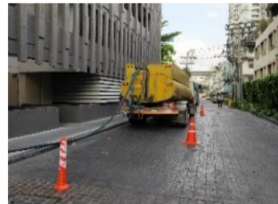
ภาพที่ 2-29 การสูบล้างและดูดตะกอนบำบัดน้ำเสีย อาคาร A และ B
